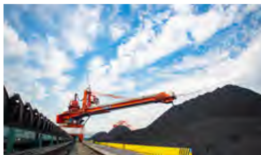
黃驊港智能化作業現場
