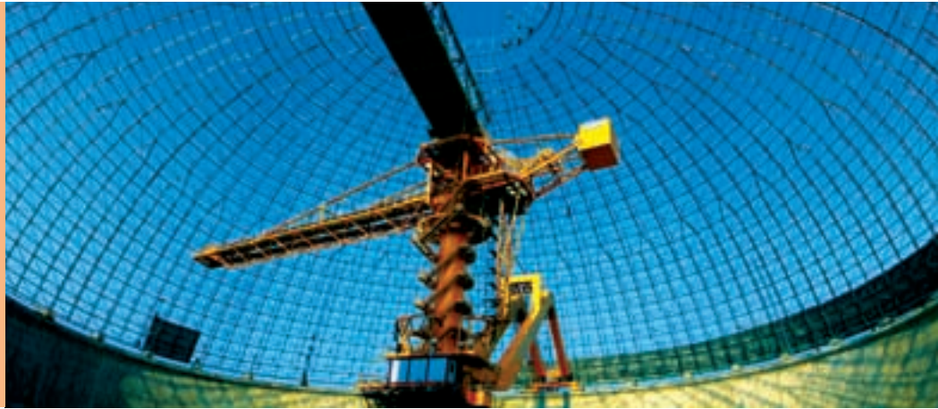
建設中的球形儲煤倉
