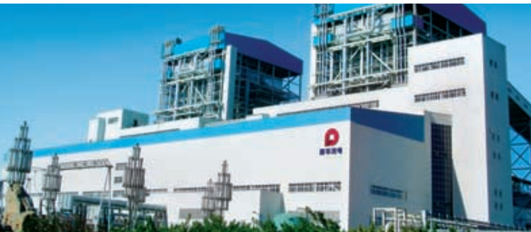
黃驊電力一期發電機組
