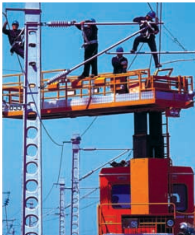
維護電氣化鐵路
